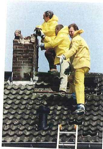
Nederlandse bevingen treffen vooral dak en schoorsteen.
